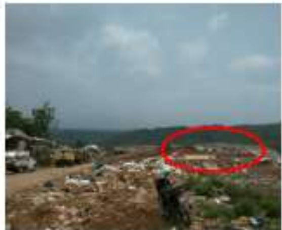
Landasan truk untuk menuangkan sampah pada landfill
