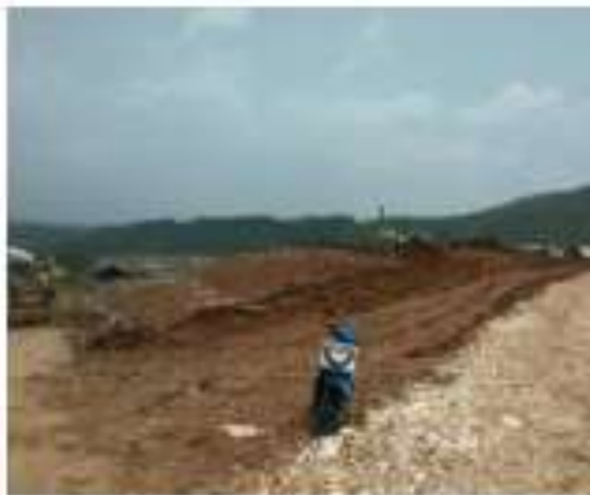
Landfill yang sedang diurug dengan tanah penutup
